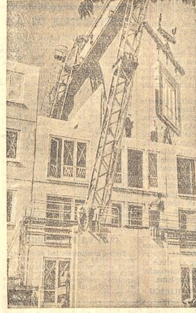
In R.D. Germană se aplică cu scară tot mai largă metode industriale în construcții. Zidarul nu mai este nevoit să se aplece de citeva sute de ori pe zi după cărămizi pentru a clădi un metru cub de zid. O brigadă de 4-5 montori poate monta cite un apartament pe zi. Iată, în fotografie, un aspect de pe șantierul unui bloc de locuințe din R. D. Germană.
