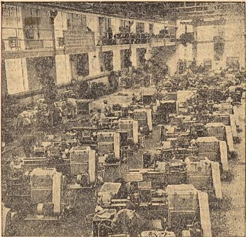
La începutul acestui an, la Atelierele C.F.R. „Grivița Roșie” din Capitală s-a dat în folosință un atelier nou de școlări. În noul atelier se confecționează diferite scule de așchiat, dispozitive, aparate pneumatice etc. necesare atelierelor și depourilor C. F. R. În fotografie: Un aspect al noului atelier. (Foto Agerpres)
