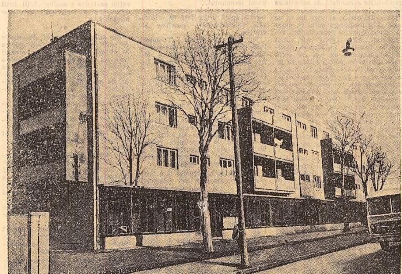
Orașul Stalin, Pe calea București, un nou bloc de locuințe. (Foto: Gh. Vințilă)
