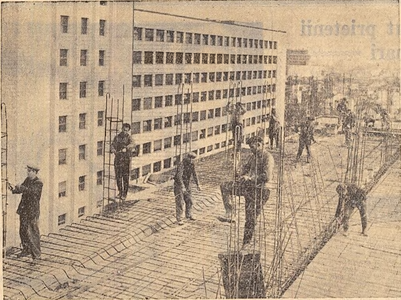
La blocul B ce se construiește pe B-dul Dinicu Golescu nr. 23-25, din Capitală, brigada de fierari-betonști condusă de Andrei Stoica montează armăturile planșului și stîlpilor de la etajul 8. De la începutul anului și pînă acum brigada a economisit peste 2.500 kg. oțel-beton. (Foto M. Cioc)
