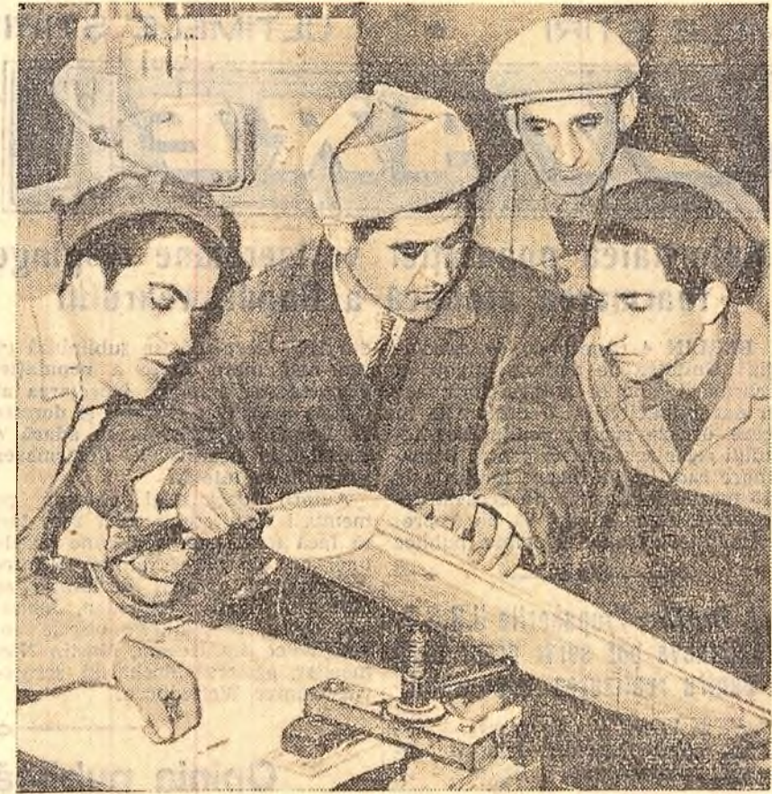
Colectivul fabricii pentru prelucrarea și montarea marmorei și pietre de construcții din Capitală execută numeroase lucrări de finisare și ornamente a noulor construcții...
