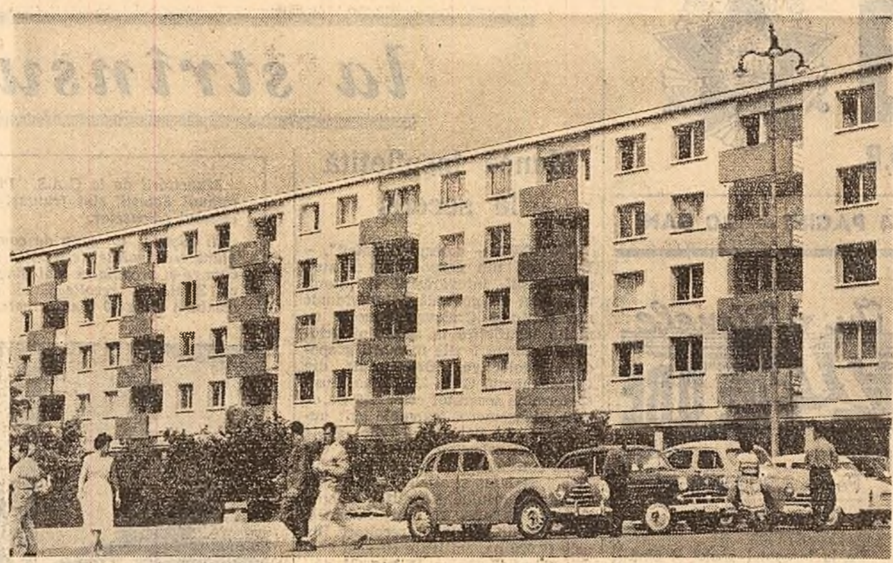
Un nou bloc de 4 etaje cu 89 apartamente a fost dat recent în folosință pe strada George Enescu nr. 2 din orașul Constanța.
