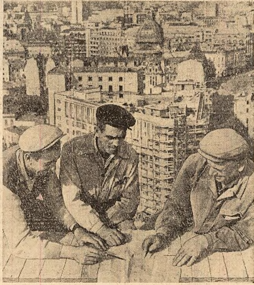
La înălțimea celor 19 nivele ale blocului din piața Splaiului din Capitală, șefii de brigăzi Nistor Munteanu, Ștefan Ionescu și Vasile Clumakov pun la punct detaliile de armătură și cofraje, în vederea turnării betonului la ultimele grinzi.
