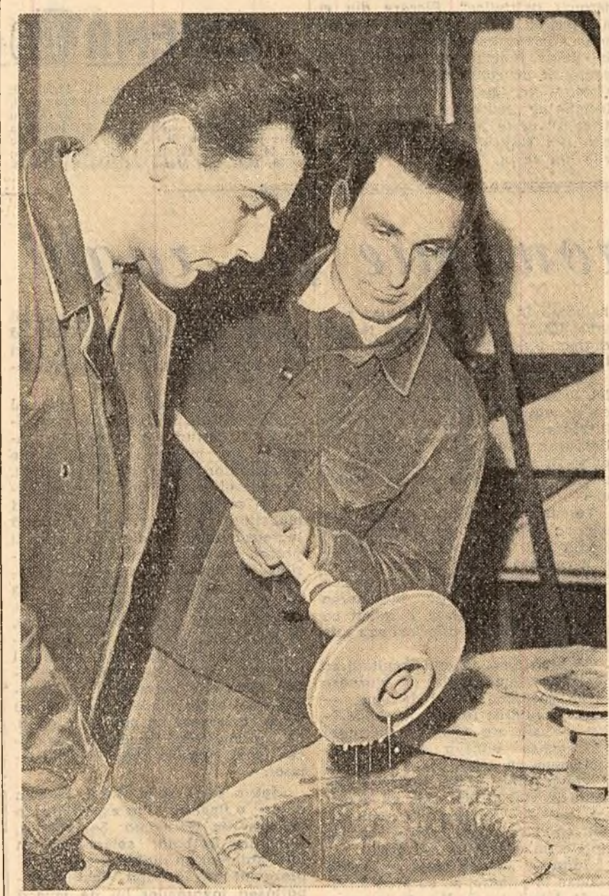
Colectivul uzinelor „Vasile Roaită” din Capitală se preocupă îndeaproape de introducerea unor procedee tehnologice moderne în producție. Unul din procedeele înaintate folosite aici cu mult succes este turnarea în forme realizate cu modele ușor luzibile. Aplicarea acestui procedeu duce la economisirea unei însemnate cantități de metal, la reducerea manoperei de prelucrare și la obținerea unor produse de bună calitate. În fotografie: muncitorul Ștefan Grama împreună cu inginerul Constantin Rădulescu, din secția turnătorie de precizie, cercetează o formă realizată cu modele ușor luzibile, pentru turnarea unui rotor de pompă centrifugă.
