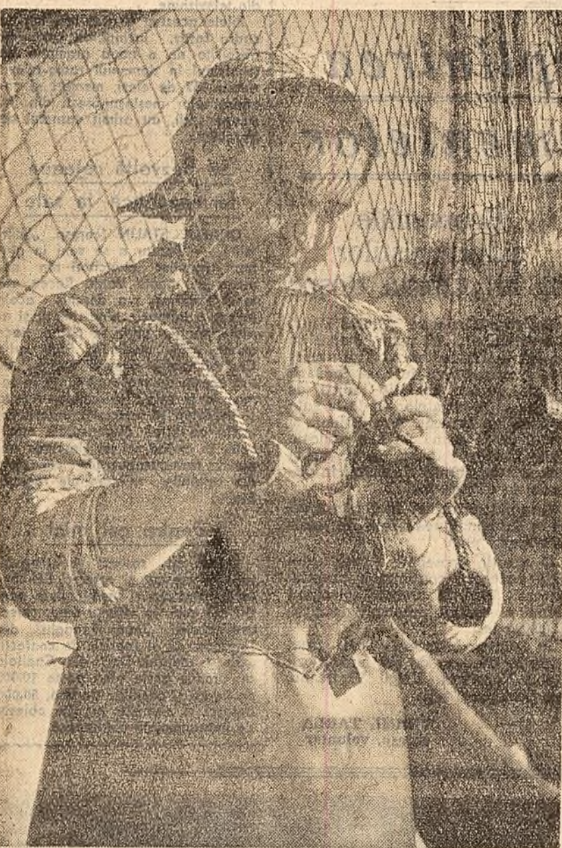
La repararea talonului.
