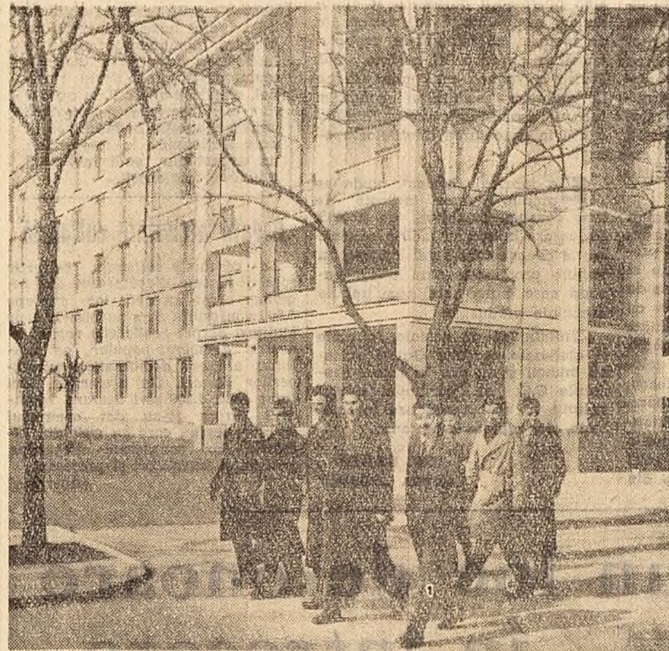
Noul cîmin studențesc cu 1.000 locuri, construit pe bulevardul 6 Martie.
