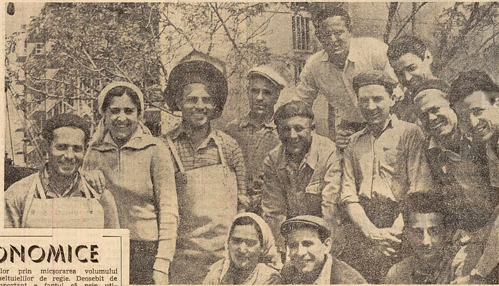
Un grup de muncitori fruntași de pe șantierul de construcție a blocurilor din panouri mari prefabricate din Piața Progresul din Capitală. (Foto: R. Costin)
