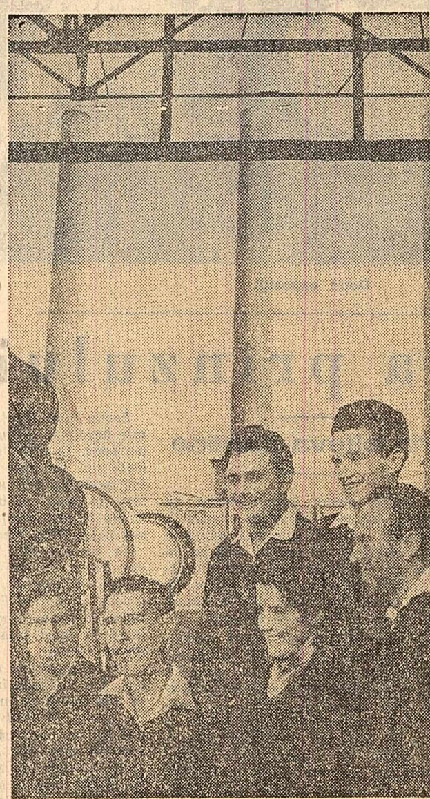
Colectivul fabricii de ciment din Medgidia a obținut în acest an realizări de seamă în îndeplinirea sarcinilor de plan. Au adus o contribuție importantă frunții în producție — Ion Chiriac, zidar; Florea Volcu, cazangiu; Elena Has, bobina-toare; Iatan Dobre, lăcătuș; Gh. Roșu, electrician și Iustin Iliescu, mecanic.
