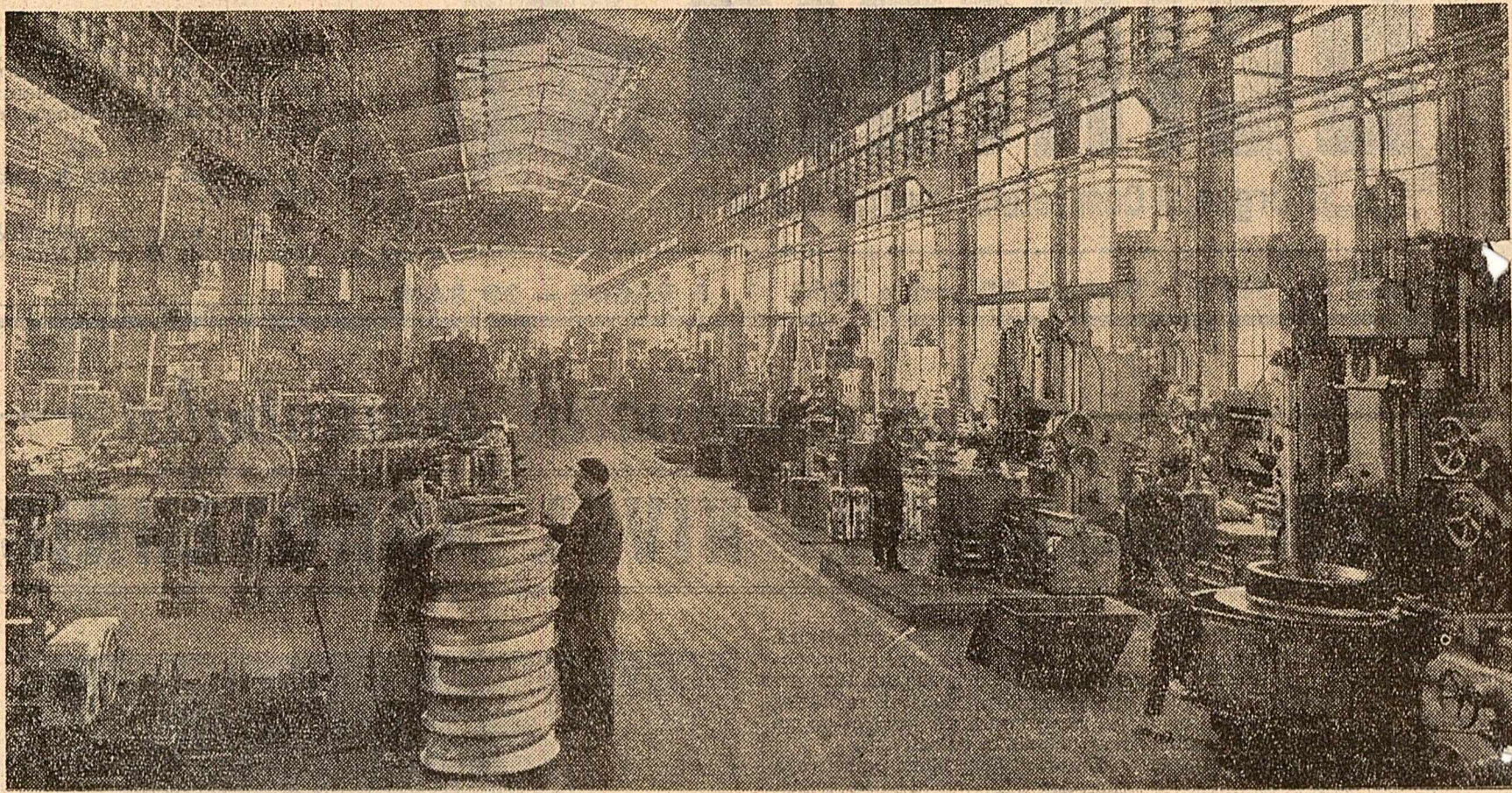
Vedere din hala de mașini grele a Uzinei constructoare de mașini Reșița. (Foto: M. Andreescu)
