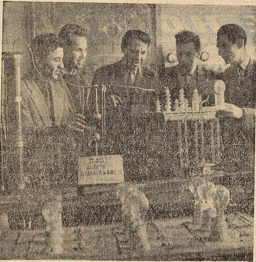
Oră de laborator a Grupului școlar al Uzinelor „Electroputer”-Craiova. Vitorii maeștri ascultând explicațiile profesorului despre funcționarea unei instalații de impuls pentru încercarea izolației mașinilor și aparatelor electrice.
