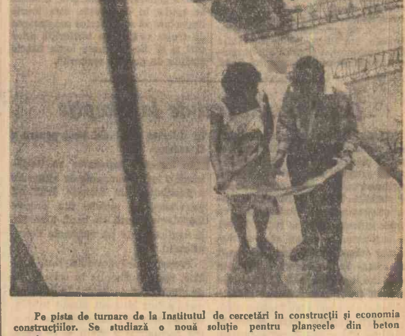
Pe pista de turnare de la Institutul de cercetări în construcții și economia construcțiilor. Se studiază o nouă soluție pentru planșeele din beton armat.
