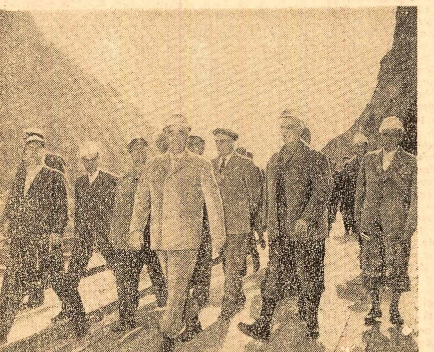
În drum spre unul din șantierele barajului
