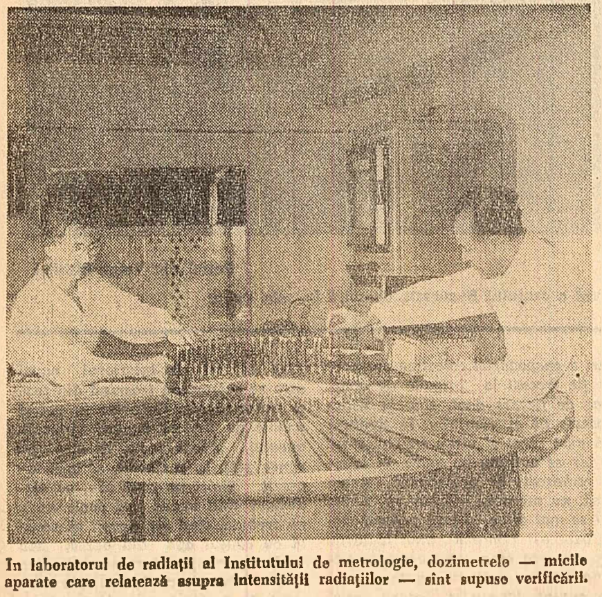
În laboratorul de radiații al Institutului de metrologie, dozimetrile — micile aparate care relatează asupra intensității radiațiilor — sînt supuse verificării.
