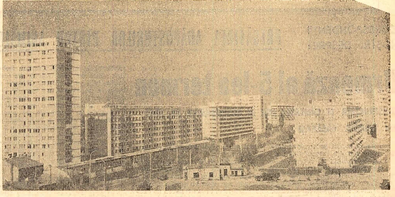
Noile blocuri de locuințe de pe șoseaua Giurgiului din Capitală Foto: Gh. Vințilă
