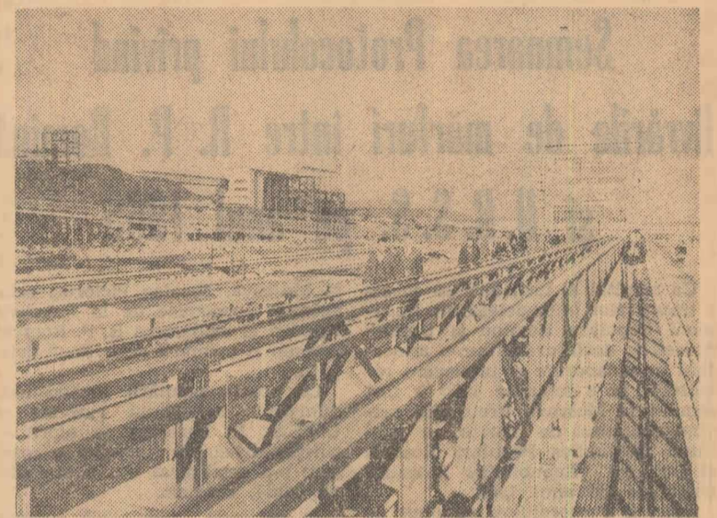
Pe șantierul de construcții al uzinei de la Vresova (R. S. Cehoslovacă) pentru valorificarea cărbunului interior
