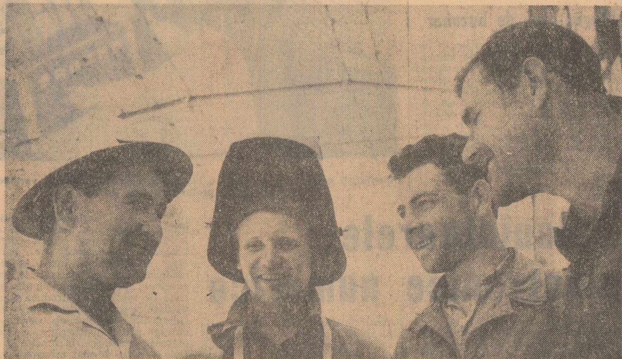
Vechi cunoscuți. De la stînga spre dreapta: Maistrul de montaj Iulian Tușu, sudorul Gheorghe Tănăsache, șeful de brigadă Gheorghe Săbău și Ștefan Purcăuș, lăcătuș. Au lăsat ani în urmă și au cîștigat experiență bogată pe șantierul construcțiilor industriale de la Hunedoara, Săvinești, Biczac ș.a. Iată-l acum pe șantierul Combinatului siderurgic din Galați
