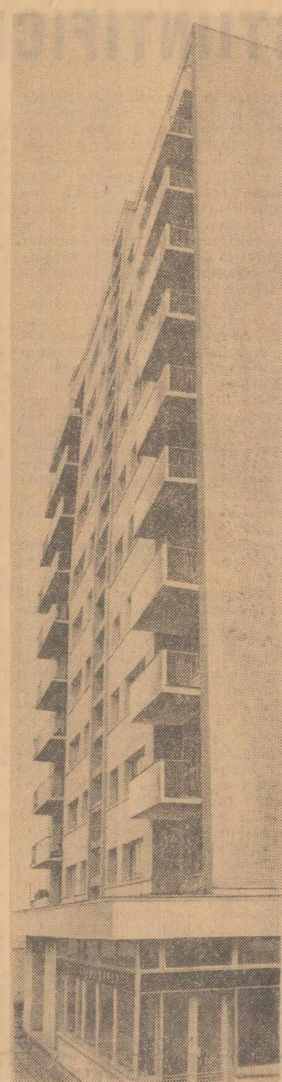
Bloc turn construit pe Calea Unirii din Craiova
