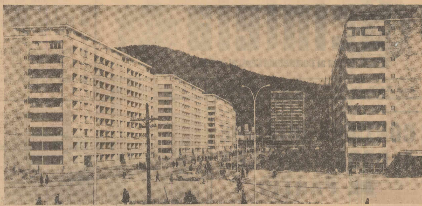
PIATRA NEAMȚ (coresp. „Scînteii”). — Constructorii de pe șantierul de locuințe din orașul Piatra Neamț au dat în folosință alte două blocuri. Este vorba despre cele 153 de apartamente înălțate pe strada Bicăzului și pe Bicăzului Chimiei, care sînt a patrulea etapă a lucrărilor. Cu acestoc numărul apartamentelor date în folosință în ultimii doi ani în orașul de pe poalele Coziei se ridică la 1.213. În acest an vor mai fi date în folosință încă 472 de apartamente care se vor construi pe străzile Alexandru cel Bun, Bicăzului și pe Bulevardul Chimiei. În fotografie: noul centru al orașului Piatra Neamț.
