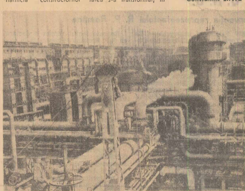
Bateia de coacșificare — pentru obținerea coacșului din lignit — de la uzinele din Lauchhammer (R. D. Germană)
