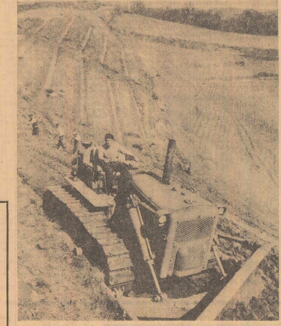
Terenurile situate în pantă sînt puse în valoare prin amenajarea lor în terase și plantarea cu viță de vie. La G.A.S. Rîchiș, regiunea Brașov, lucrările de terasare se execută mecanizat.
