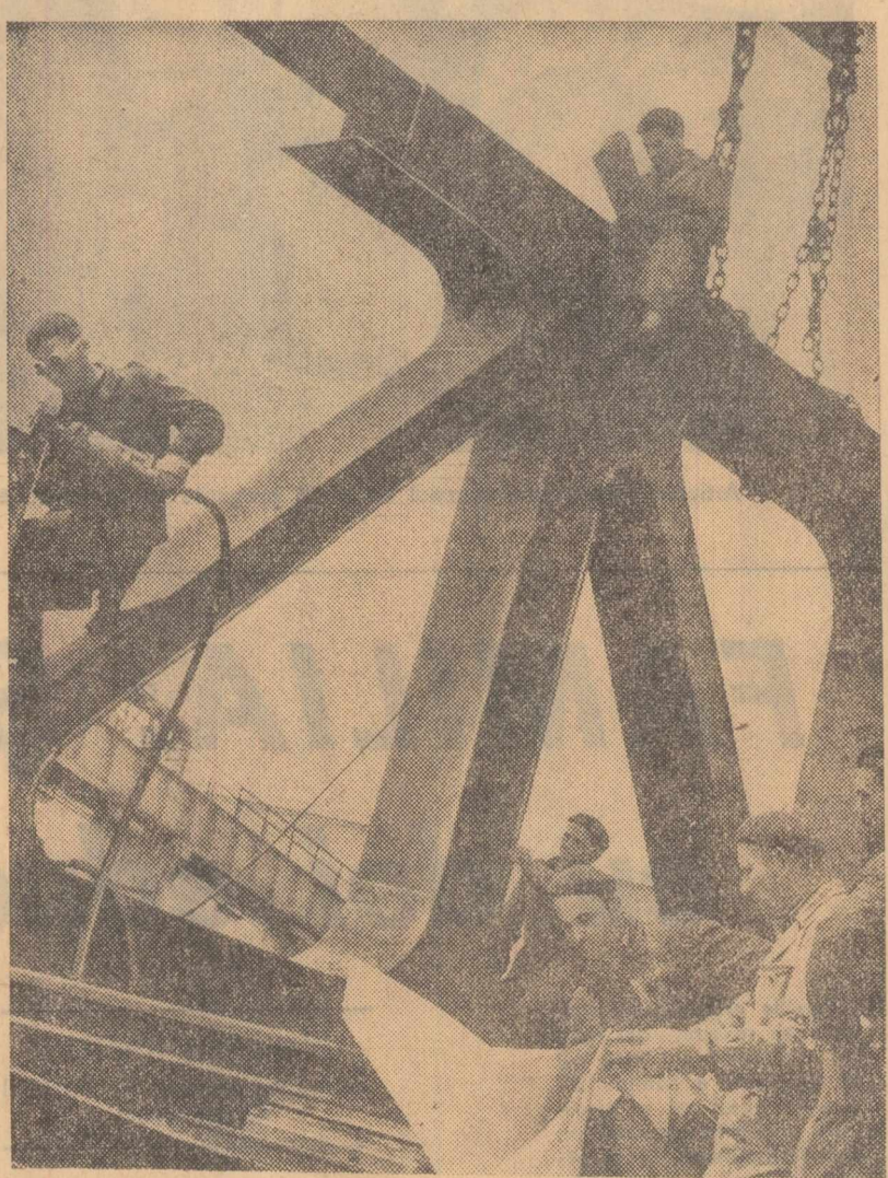
Uzina de construcții metalice și mașini agricole din Bocșa. Se lucrează la o macara portal, de 32 tone, destinată combinatului siderurgic „Gh. Gheorghiu-Dej” din Galați. Foto: R. Costin
