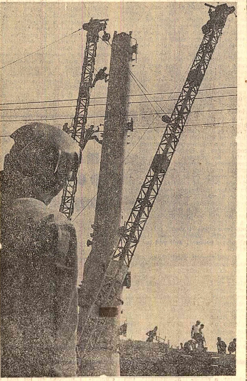
Pe șantierul Rafinării din Pitești. Foto: M. Andreescu
