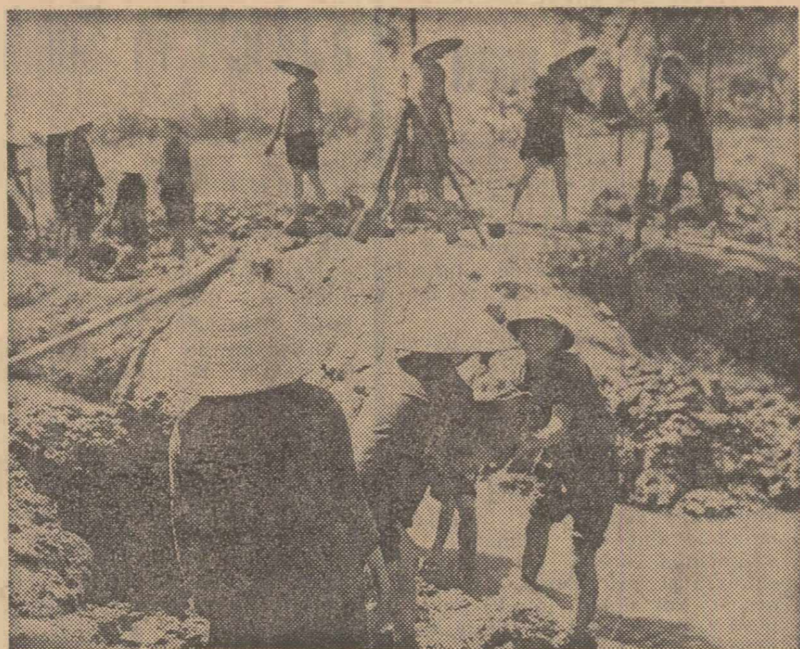
R. D. Vietnam. Dind dovadă de eroism și abnegație patriotică, țărani vietnamezi repară stricăciunile provocate digurilor și sistemelor de irigații de pe urma bombardamentelor americane. În fotografie: refacerea digului de lângă satul Haulok
