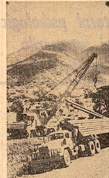
Intre Tanzania și Zambia a fost construită o conductă petroliferă, prin care Zambia va fi aprovizionată cu petrol. În fotografie: amplasarea ultimilor metri de conductă pe teritoriul Tanzaniei.
