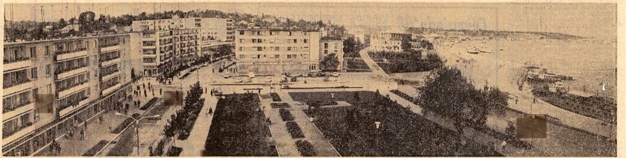
Construcții noi în municipiul Tulcea
