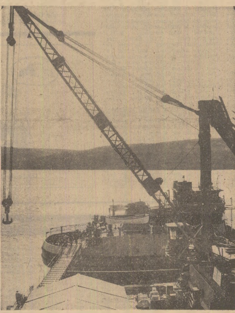
Șantierul naval Oltenița: Se finalizează o nouă navă de 5000 tone. Foto: S. Cristian
