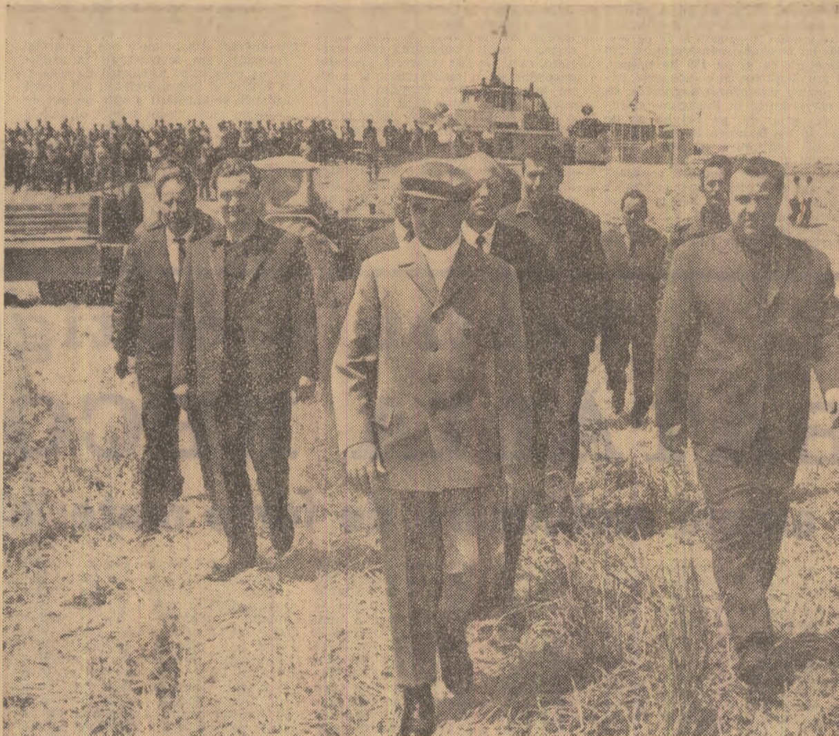
În zona digului de la Vlădeni
