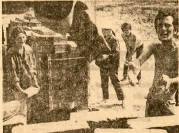
Pe două șantiere ale muncii patriotice din Capitală. Studenții de la Institutul de arhitectură la fabrica de cărămidă „7 Noiembrie” (stînga). Elevi brigadiieri de la liceul „I. Neulce” pe șantierea Clubului nautil pentru tineret de la Străulești. Foto: S. Cristian
