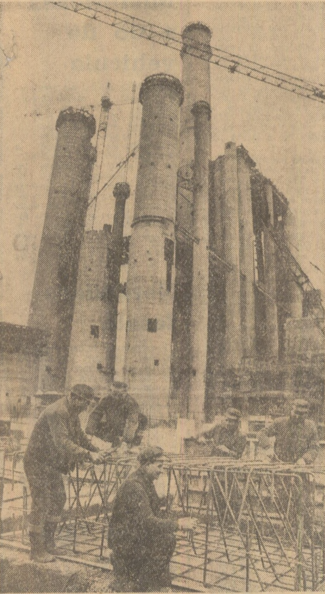
După punerea în funcțiune a primului grup hidroenergetic, eveniment care a avut loc recent, pe șantiierul termocentralei Rogojelu munca continuă în ritm susținut, constructorii străduindu-se să cîștige un avans cât mai mare în lupta cu timpul. În fotografie: brigada de fierari-betonisti, condusă de maestrul Nicolae Diaconu, aflată în primele rinduri ale întreprinderii. Foto: S. Cristian
