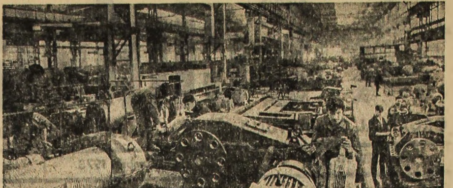
In secția de mașini de ridicat de la Întreprinderea mecanică din Timișoara, echipa condusă de Ilie Circioban lucrează la asamblarea cărucioarelor pentru podurile rulante destinate platformei industriale de la Tirgoviște. Foto: E. Dichieșanu
