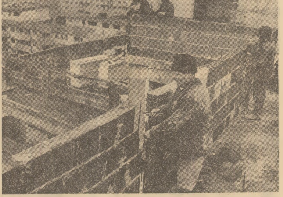
Blocul 114 B din cartierul Pantelimon - Iancului. Constructorii Marin Matei, Nicolae Micu și Nicolae Umbrărescu lucrează sus la înălțime - pe terasa blocului, care va fi dat, în funcțiune cu o lună mai devreme
