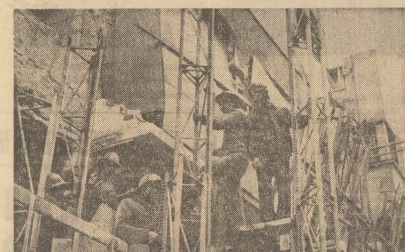
Brigada maistrului mecanic Constantin Oaşcă, din cadrul Trului de construcţii industriale şi agrozootehnice din Bucureşti, lucrează la montarea schelelor autoriducătoare pentru consolidarea şi refacerea grăbnică a clădirii din Bulevardul Republicii nr. 85. Foto: I. Ştefan
