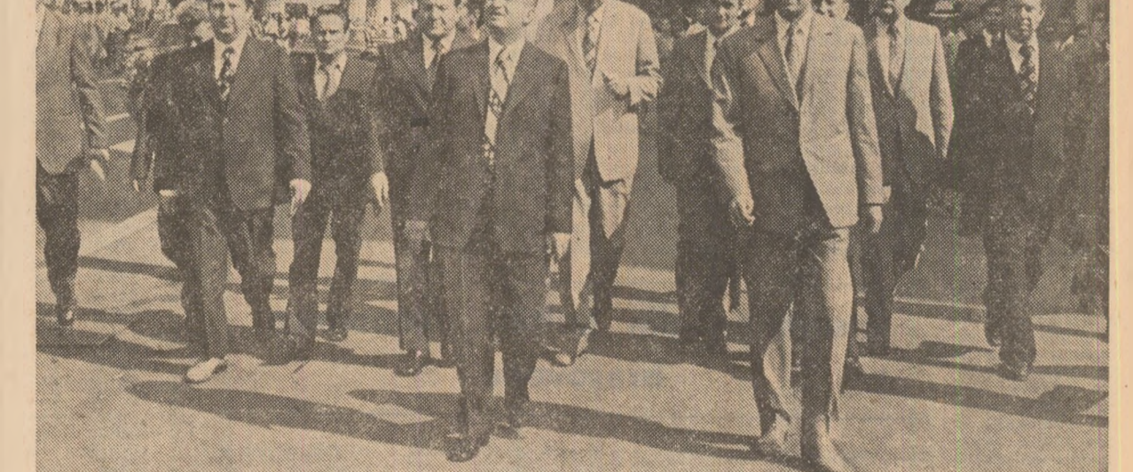
Pe Calea Victoriei se examinează mersul lucrărilor de reconstrucție
