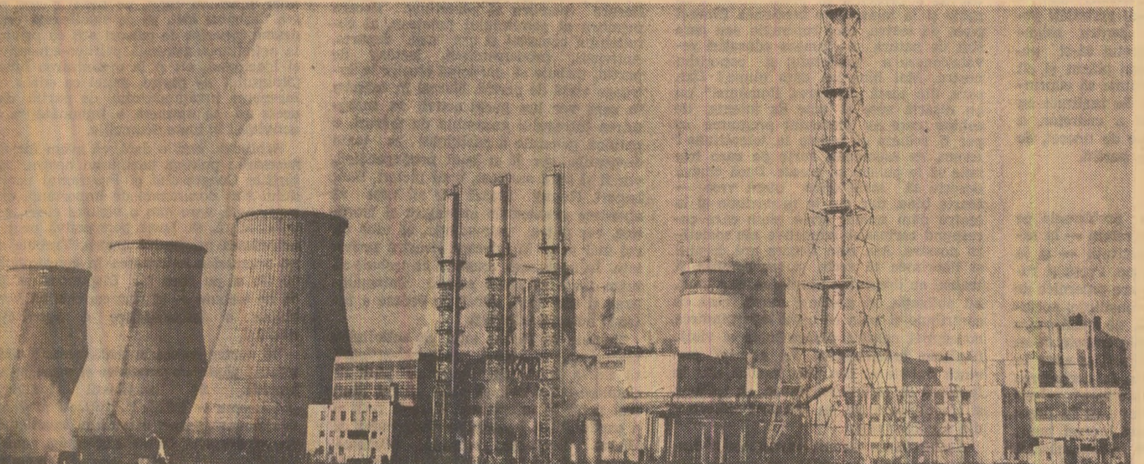
Vedere parțială a combinatului chimic „Azomureș” din Tg. Mureș
