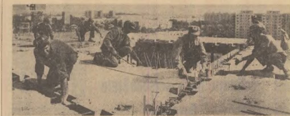
Blocurile de locuințe ridicate de constructorii bacăuani pe Bd. Păcii se apropie de casa finală. Cum au acționat în acest scop? Acordul global este aplicat integral, s-au introdus policalificarea muncitorilor și lucrul în 2 schimburi prelungite. Foto: S. Cristian
