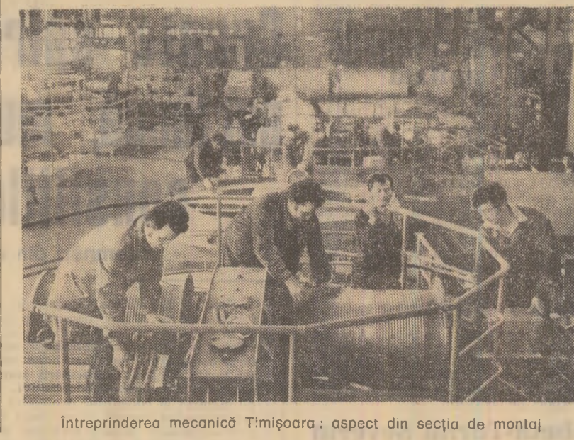
Întreprinderea mecanică Timișoara: aspect din secția de montaj
