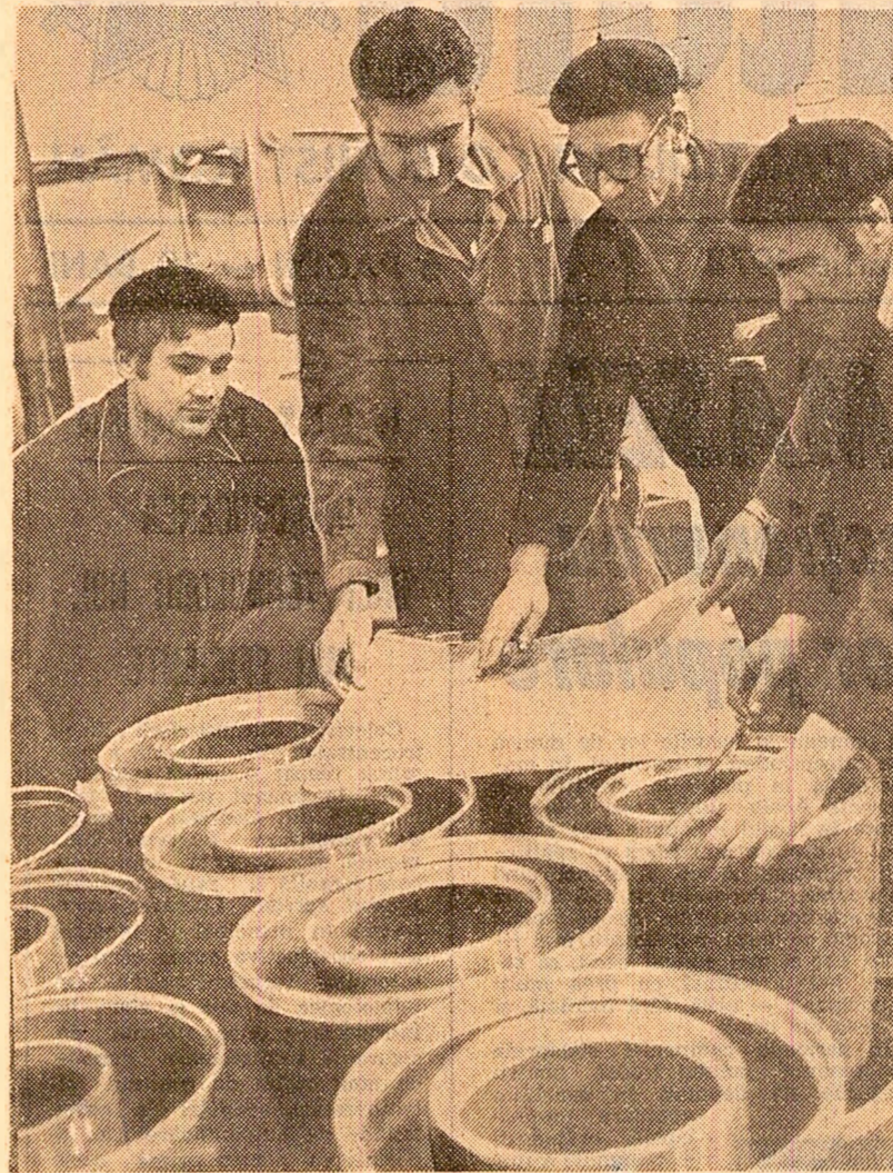
Ce ne aduce sub priviri fotografia de față? O imagine obișnuită de muncă de la Uzina de piese de schimb și reparații siderurgice de pe platforma combinatului siderurgic gălățean. O imagine în care Pompiliu Severineanu, Petrică Năstase, Virgil Chirilă și Gheorghe Soare rezolvă o problemă de producție curentă la gurile de vînt pentru furnale. Ce nu se vede în fotografie este tocmal efortul uman de a pune în valoare inteligența, potențialul inovator și dăruirea din care se nasc aceste instalații de mare eficiență economică
