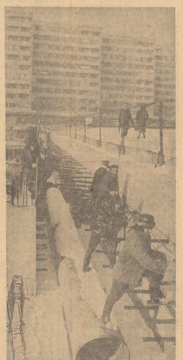
Zile de iarnă pe șantierul pasajului rutier denivelat din Piața Obor din Capitală
