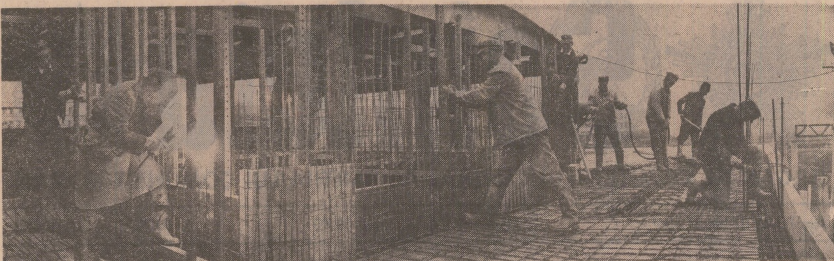
Constructor — o meserie, o vocație a locuitorilor de pe mealegruul județului Bistrița-Năsăud. În acest cincinal ei au de realizat un volum de investiții de peste 5 ori mai mare decît în cincinalul 1971—1975. În fotografie: șantierul Fabricii de cabluri din Bistrița Foto: E. Dichiesanu
