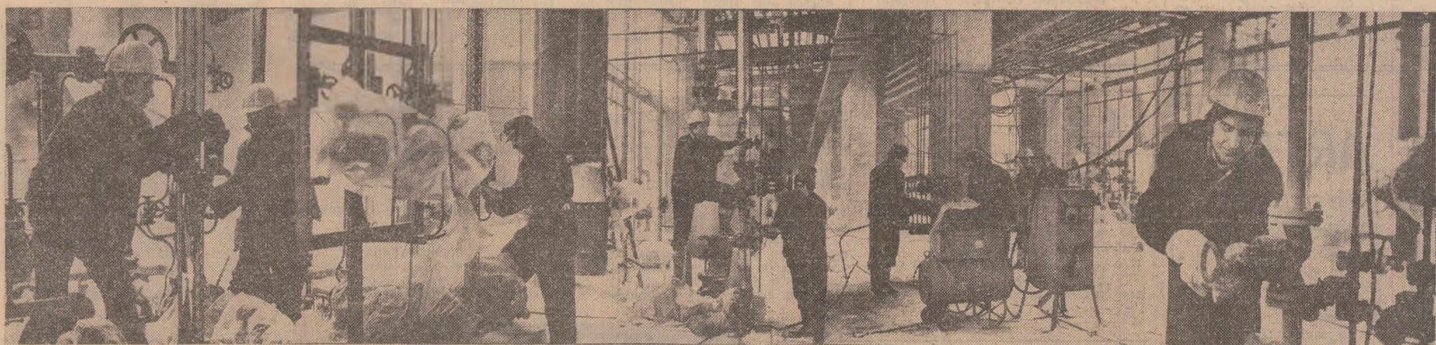
Pe unul din șantierelor timișorene: echipa de montori, condusă de Culiță Flondor, execută lucrări în cadrul combinatului petrochimic „Solventul” Foto: E. Dîchiseanu
