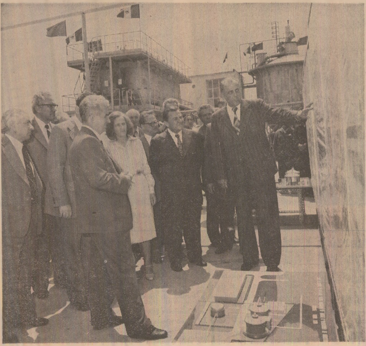
La stația-pilot de la Periș, pentru producerea biogazului
