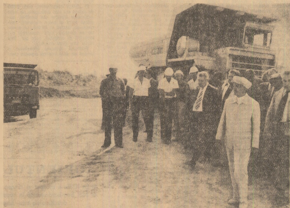
La cele două puncte de lucru vizitate — km 23 și km 60 — secretarul general al partidului trasează noi sarcini pentru accelerarea ritmului de execuție a lucrărilor
