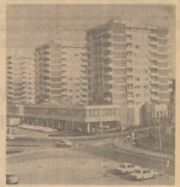
Noi construcții de locuințe în Piața Unirii din Craiova
