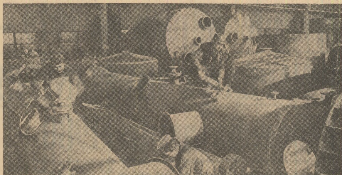
Întreprinderea de utilaj chimic București: se lucrează intens la un nou lot de utilaje destinate șantierelor chimiei Foto: S. Cristian
