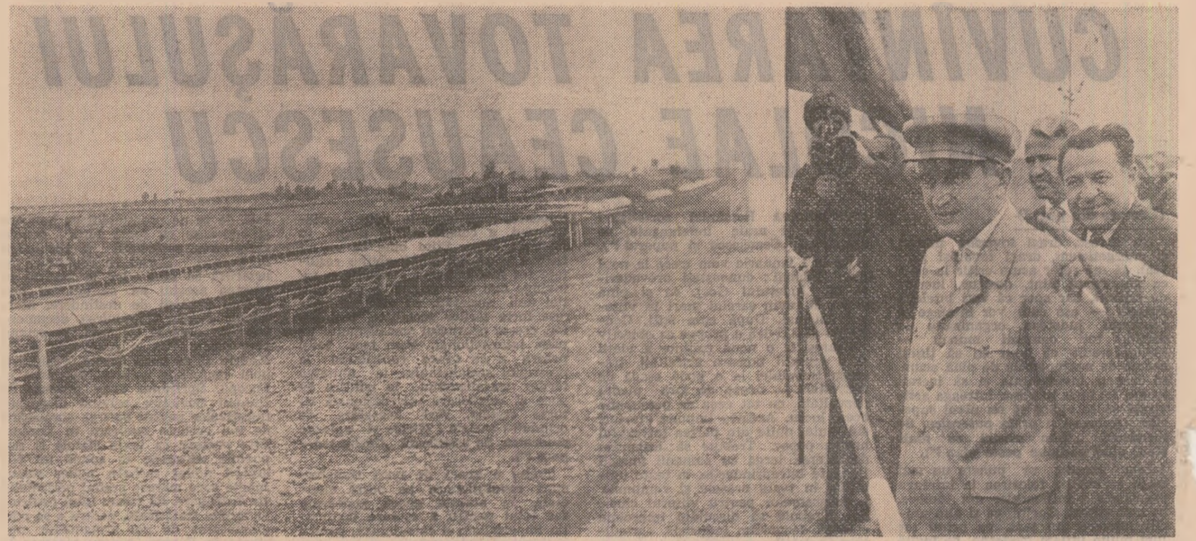
ROVINARI: Cuvinte de apreciere pentru munca desfășurată, propuneri de noi soluții pentru mai bună funcționare a agregatelor termocentralei
