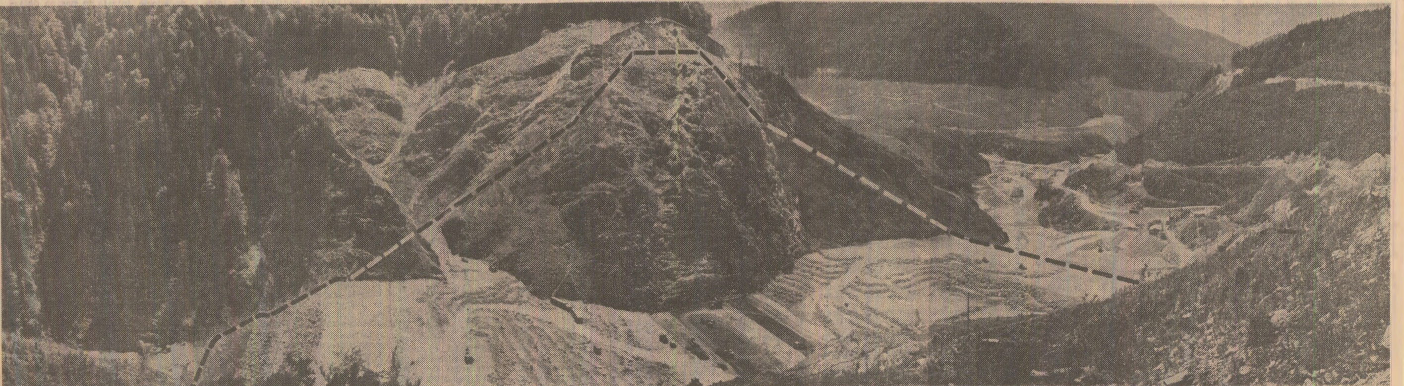
Cel mai mare baraj de anrocamente din Europa se construiește aici, în inima munților Retezat. Linia punctată marchează viitorul contur al barajului.
