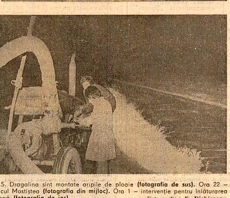
Raid de noapte în sistemele de irigații din județul Călărași. Ora 19 — la I.A.S. Dragalina sînt montate aripile de ploaie (fotografia de sus). Ora 22 — o stație de pompare este traversată peste șosea pentru a fi instalată pe lacul Mostiștea (fotografia din mijloc). Ora 1 — intervenție pentru înălțurarea unei defecțiuni la o motopompă (fotografia de jos)
